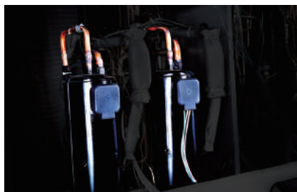
Plusieurs compresseurs Inverter de grande capacité (plus de 14 CH).
